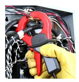
**Photo 2**: Install CT Around Conductor.
